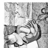
**2** Rialcalinizzazione del conglomerato mediante applicazione a spruzzo di trattamento consolidante, reattivo, incolore, basato su silicati alcalini in dispersione acquosa, **CONSILEX SAN**, per un consumo medio di circa 0,25 litri/m<sup>2</sup>. L'applicazione, che deve essere effettuata su supporto umido, non comporta attese per gli interventi successivi.
