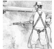
**2** Predisposizione degli ancoraggi per l'armatura aggiuntiva, eventualmente necessaria o prescritta, mediante spezzoni di acciaio fissati in opera in fori opportunamente predisposti, con impiego della specifica boiaccia d'ancoraggio **GROUT CABLE** e successiva messa in opera ed ancoraggio dell'eventuale armatura addizionale (rete d'acciaio elettrosaldato, di diametro e maglia adeguate alla funzione strutturale individuata).
