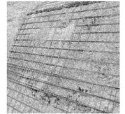
Ripetere l'idrolavaggio delle superfici per restituire un supporto saturo, a superficie asciutta, all'atto dell'operazione di spruzzo.
