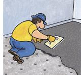
**6** Sul microcalcestruzzo fresco, immediatamente dopo il getto, applicazione a spruzzo o rullo di antievaporante **CURING AID**. L'antievaporante forma uno strato protettivo che riduce drasticamente l'evaporazione dell'acqua d'impasto nelle prime fasi di indurimento del prodotto. In alternativa utilizzare teli in PE.
