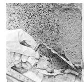
**5** Dopo qualche giorno dal termine delle operazioni di iniezione, l'intonaco fatiscente va generalmente rimosso per consentire una migliore asciugatura della muratura trattata. A completo asciugamento del muro stonacato è consigliato il rifacimento del nuovo intonaco con ciclo di intonaci macroporosi, risananti, deumidificanti (**UNTERSANA, SANATIGH, SANASTOF**).
