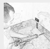
**4** Una volta terminata l'iniezione si potranno chiudere i fori utilizzati per l'iniezione del **CONSILEX BARRIER CREAM** con una malta cementizia o alla calce.
