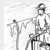
**6** Rimozione degli iniettori dopo verifica delle corrette condizioni di reazione e maturazione della resina. Asportazione della resina fuoriuscita mediante raschietto e/o spazzola con setole metalliche.
