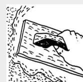
**8** Realizzazione dello strato di finitura, mediante applicazione a frattazzo, dello specifico intonachino rasante, traspirante, bioedile, **SANASTOF**, per un consumo indicativo di 4 kg/m<sup>2</sup>. Attendere minimo 21 giorni (a 20°C) per l'applicazione delle pitture traspiranti.
