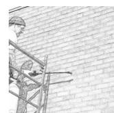
L'applicazione, mediante nebulizzazione a bassa pressione o con pennello dovrà essere effettuata in una o più mani, senza eccessive soluzioni di continuità o intervalli di tempo, curando la migliore saturazione del tessuto murario.
