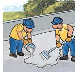
**2** Applicazione, mediante spazzolone con setole di plastica dura, sui supporti saturi d'acqua a superficie asciutta, della soluzione indurente e consolidante, costituita da acqua e **QL FLUOSIL**, in 3 mani successive e di differente concentrazione:
