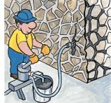
**5** Esecuzione del consolidamento mediante iniezione della speciale boiaccia ad elevatissima stabilità dimensionale, a base di calce idraulica, **SANAFLUENS**, preparata con le modalità sopra indicate. Le iniezioni, eseguite partendo dal basso verso l'alto, dovranno essere effettuate a bassa pressione in costanza di alimentazione, ed eventualmente ripetute, ove necessario sino al sicuro soddisfacimento delle effettive esigenze di consolidamento.
