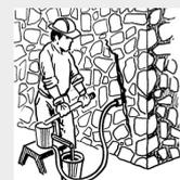
Il consumo effettivo di prodotto, definibile attraverso il parametro indicativo di kg 1,5 per litro di riempimento (1.500 kg/m<sup>3</sup>), potrà variare in funzione dell'entità dimensionale e della diffusione delle sezioni da riempire e consolidare.
