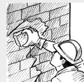
**2** Applicazione della specifica soluzione di speciali organosilossani in solvente **CONSILEX ALTRAIN**, waterproofing, idrorepellente, incolore, traspirante. L'applicazione, mediante nebulizzazione a bassa pressione o con pennello dovrà essere effettuata in una o più mani, senza eccessive soluzioni di continuità o intervalli di tempo, curando la migliore saturazione del tessuto murario.
