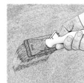
N.B.: Per condizione "satura a superficie asciutta", si intende lo stato di un supporto che, bagnato qualche ora prima, ha assorbito completamente l'acqua che vi è stata applicata, sino ad asciugarsi in superficie. In questo modo il supporto non sottrae acqua al materiale applicato e superficie non presenta veli d'acqua che possono interpersi fra i due materiali, pregiudicando l'adesione.
