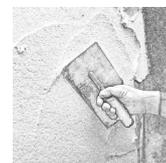
**7** Finitura protettiva delle superfici mediante applicazione, a pennello, rullo o spruzzo della pittura pigmentata **PROTECH WAC-T**, a base di elastomeri acrilici e polimeri fluorurati termoplastici (teflon), altamente resistente al passaggio della CO<sub>2</sub>, traspirante al vapore acqueo, certificata UNI EN 1504/2. Consumo di circa 0,30 kg/m<sup>2</sup> in due mani.
