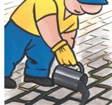
7 Stesura di segatura di legno, sulle superfici della pavimentazione e successiva spazzolatura a "sfregamento" da effettuarsi dopo circa 30' rispetto alla posa della micromalta di stilatura.
