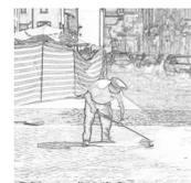
8 Ad avvenuta stagionatura, lavaggio di finitura delle superfici mediante idropulitrice.
