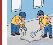
**5** Applicazione, mediante spazzolone con setole di plastica dura, sui supporti saturi d'acqua a superficie asciutta, della terza mano di soluzione indurente e consolidante costituita da acqua e **QL FLUOSIL**, nel rapporto 1:1 (una parte d'acqua ed una di prodotto, in peso). Per i tempi di attesa vedere nota in calce (\*).
