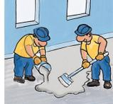
**5** Applicazione, mediante spazzolone con setole di plastica dura, sui supporti saturi d'acqua a superficie asciutta, della terza mano di soluzione indurente e consolidante costituita da acqua e **QL FLUOSIL**, nel rapporto 1:1 (una parte d'acqua ed una di prodotto, in peso). Per i tempi di attesa vedere nota in calce (\*).
