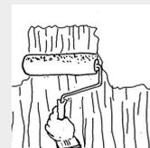
**4** Applicazione dello specifico fondo microporoso anticavillature, microfibrato **SANAXIL FILLER**, a base di silicato di potassio, microfibre, cariche, ed agenti specifici, dato a rullo o pennello, tal quale, o diluito con **SANAXIL FIX** (10-15%), in funzione del tipo di supporto e delle condizioni applicative, per un consumo di 0,30-0,50 kg/m<sup>2</sup>.
