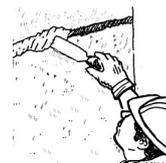
**3** Applicazione preliminare dello specifico fissativo/consolidante, **SANAXIL FIX**, a base di silicato di potassio (tal quale o diluito con acqua sino ad un rapporto massimo di 1:1), in funzione del tipo di supporto e delle condizioni applicative, dato a pennello, rullo o spruzzo, per un consumo di circa 0,12 l/m<sup>2</sup>.
