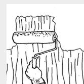
Il coefficiente di resistenza alla diffusione del vapore ( $\mu$ ) delle pitture utilizzate dovrà, comunque, essere inferiore a 11.
