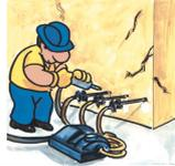
**8** Una volta saturata la muratura, attendere qualche ora e poi richiudere (tappare) le perforazioni effettuate con la malta cementizia **REPAR TIX**.
