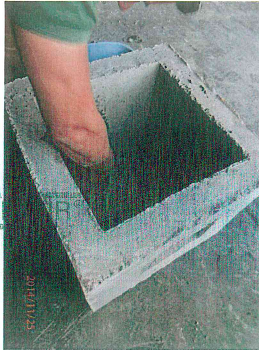
Particolare dell'applicazione dello strato di malta impermeabilizzante.
