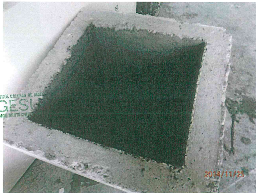
Particolare dell'impermeabilizzazione di uno dei depositi.
