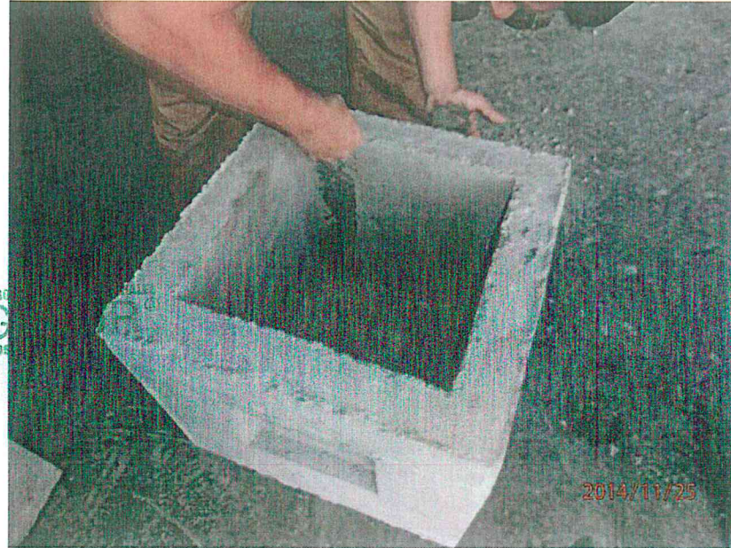
Particolare dell'applicazione dello strato di malta impermeabilizzante.
