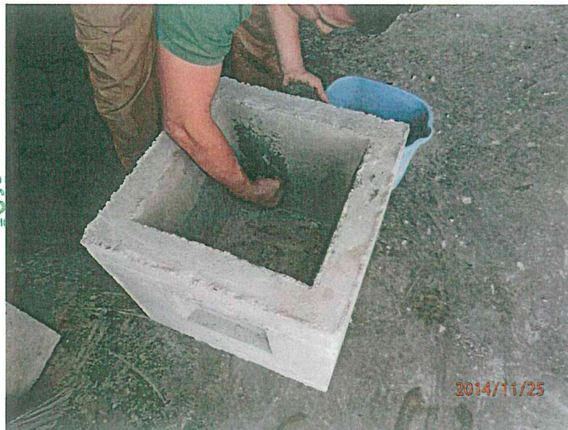
Particolare dell'applicazione dello strato di malta impermeabilizzante.
