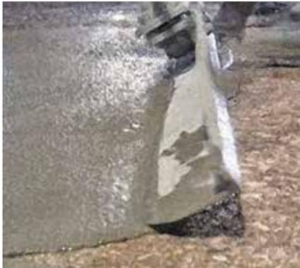
mità di chiusini o pilastri) è possibile eseguire ulteriori tagli rispetto ai giunti della pavimentazione ripristinata, per favorire uno scarico omogeneo delle tensioni ed evitare il più possibile fessurazioni sul microcalcestruzzo. La sigillatura dei giunti deve essere eseguita mediante estrusione del sigillante poliuretano **PROTECH FLEX** di AZICHEM srl.
