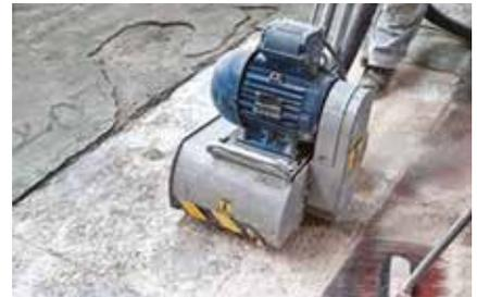
**2** Al termine delle operazioni di scarifica, **asportazione dei detriti e aspirazione delle polveri residue tramite aspiratori professionali. Idrolavaggio a pressione delle superfici in calcestruzzo con saturazione del supporto.**
