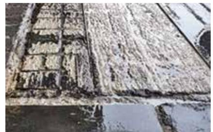
**3** Sulla superficie della pavimentazione fresata, depolverizzata e opportunamente idro lavata, realizzazione di un reticolo di 2 fori/mq, forando il supporto con fori profondi 5 cm e di larghi 14 - 16 mm. Inserimento nei fori di spinottature realizzate con barre in acciaio inox HELIX STEEL AISI 304 (Ø 6 mm) di AZICHEM srl, piegate a "L" (lato corto di 5 cm inserito nel foro e lato lungo esterno di 10 cm parallelo alla superficie).
