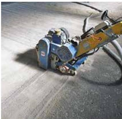
**2** Al termine delle operazioni di scarifica, **asportazione dei detriti e aspirazione delle polveri residue** tramite aspiratori professionali. **Idrolavaggio a pressione delle superfici in calcestruzzo** con saturazione del supporto (supporto saturo senza pozze di ristagno d'acqua).
